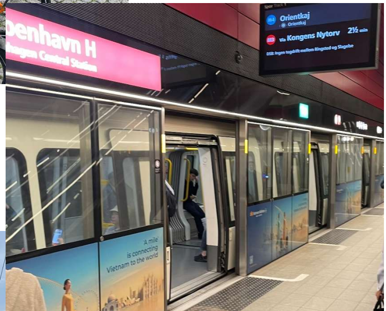
Metro mit Doppeltüren bei Abfahrt der Bahn ist das Gleisbett verschlossen
